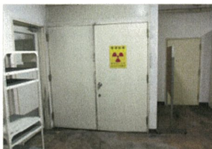
写真 2 建物内管理区域境界 (7/2 朝撮影)
