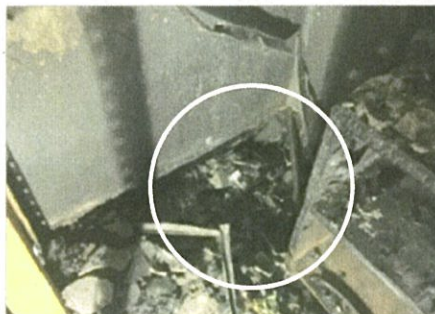
写真 8 火災が発生した実験室 西南側 In-111 があった場所付近(鎮火直後に撮影)
