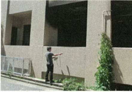
写真 9 外壁を GM とスミア法にて測定 (7/2)
