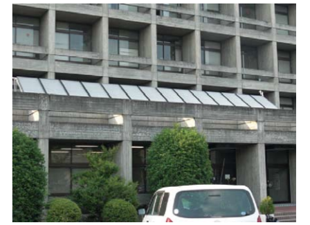
図2 建物入口屋根に設置されたソーラーナチュラルチャー
