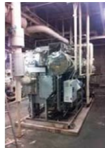
蒸気焚吸収式冷温水機 (440RT) (三菱製) × 2台 蒸気熱交換器 (1,070kW) (森松工業) × 2台
