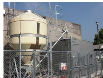
図1 木質ペレット焚ナチュラルチャーの概観
