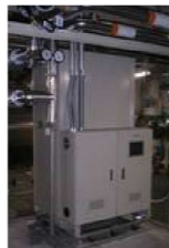
蒸気焚吸収式冷温水機 (440RT) (三菱製) × 2台 蒸気熱交換器 (1,070kW) (森松工業) × 2台
