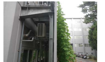
エアコンの室外機周囲の温度が低下するため熱交換効率が向上し、省エネにつながる
