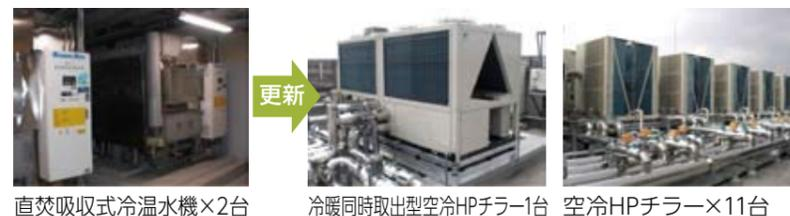
直焚吸収式冷温水機×2台      冷暖同時取出型空冷HPチラー1台      空冷HPチラー×11台
