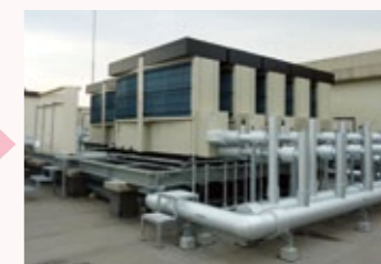
高効率空冷ヒートポンプモジュールチラー (150kW×7台、ダイキン製)
