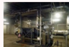
蒸気吸収式冷凍機 (1,050kW)
