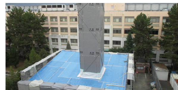
除染作業養生状況
