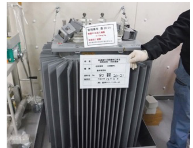
PCB保管状況
