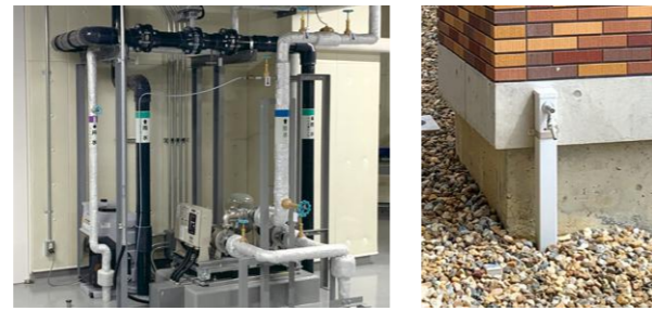
集約した雨水を送水するポンプ
