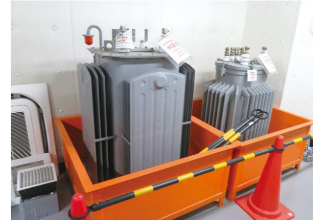
PCB保管状況
