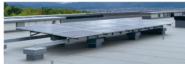
屋上 太陽光発電設備
