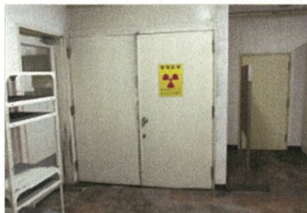
写真 2 建物内管理区域境界 (7/2 朝撮影)
