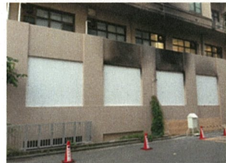
写真 12 実験室外の耐震壁開放部にカバーを設置
