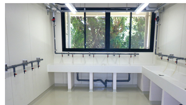
研究棟（瀬戸団地）建物内観
