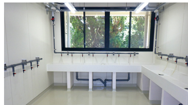
研究棟（瀬戸団地）建物内観
